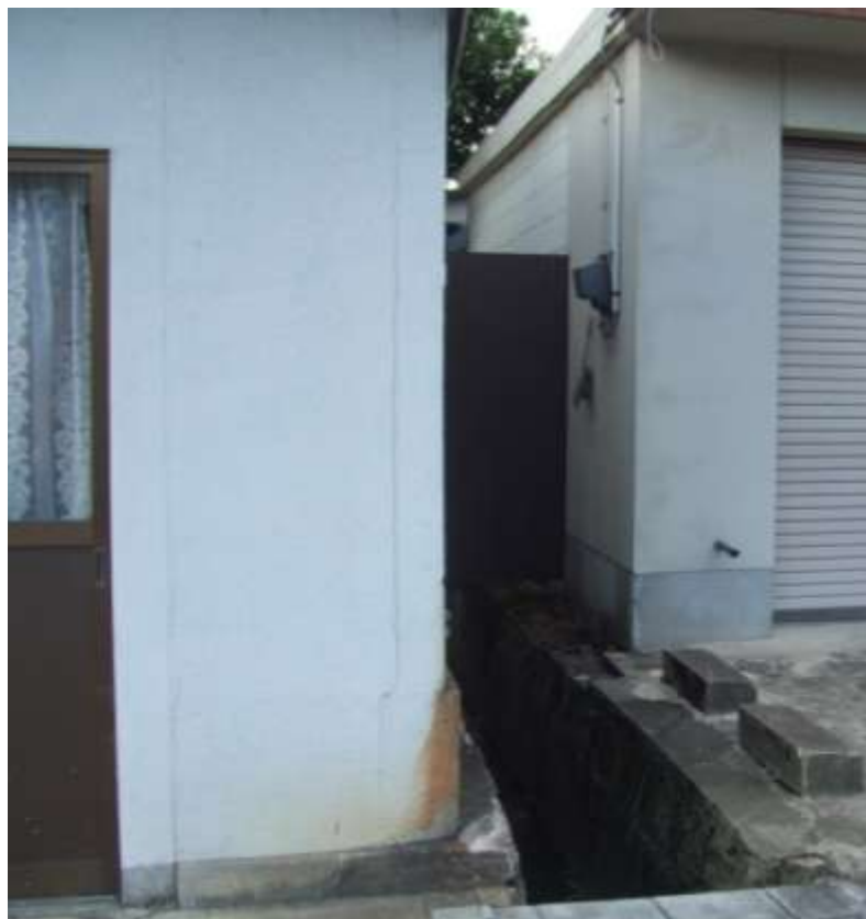
隠された背割水路
